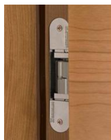
zárubeň Normal bezpolodrážkové provedení, skryté závěsy
