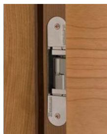
zárubeň bezpolodrážkové provedení, skryté závěsy
