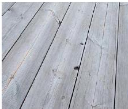
Neošetřená terasa Lunawood (termicky modifikovaná borovice) 2 roky po montáži. Na povrchu jsou vidět drobné vlasové praskliny.
