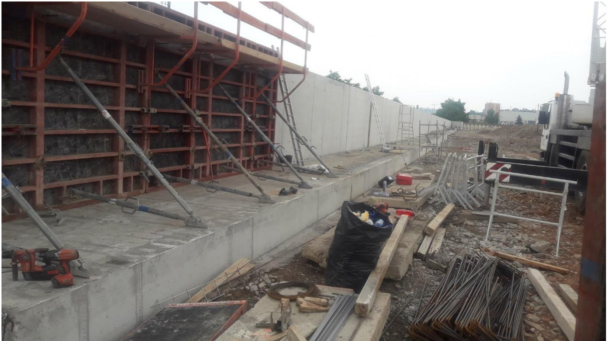
Obr 2: základový pas a opěrná stěna z Rebetongu před železniční tratí
