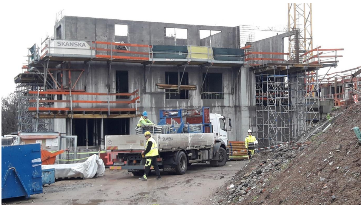
Obr.4: pohled na rozestavěný objekt A3, od 2. NP jsou již stěny z Rebetongu
