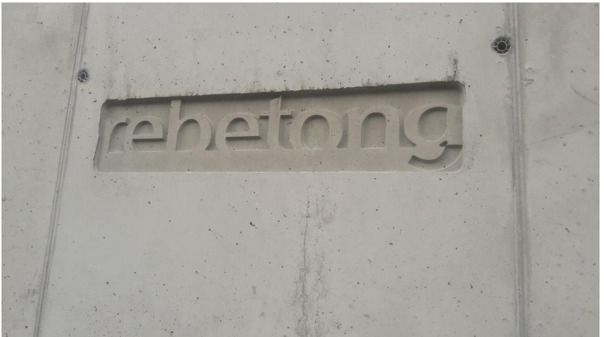
Obr.3: část opěrné stěny z Rebetongu před železniční tratí
