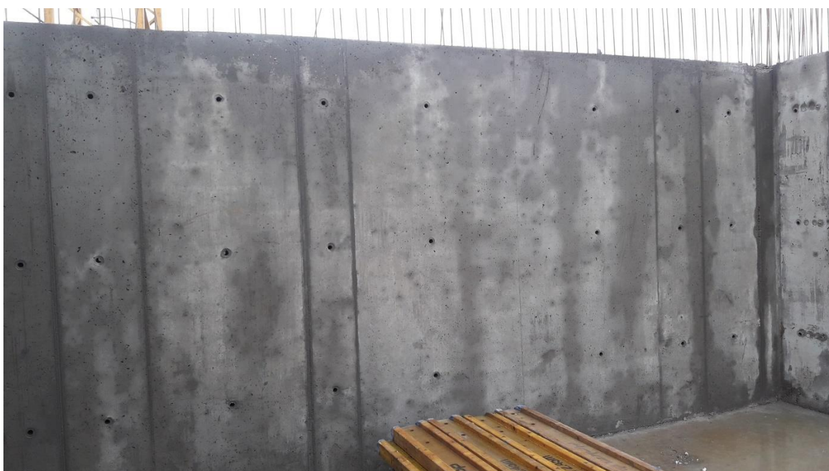
Obr.5: detail na odbedněnou stěnu z Rebetongu
