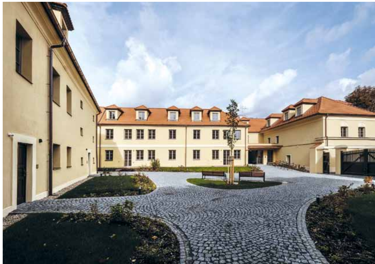
Rezidence Hendlův dvůr, Praha – Hanspaulka
