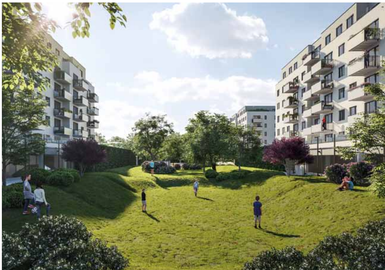
V prostoru mezi domy pracujeme s terénními průlehy a poldry, které pomáhají zadržovat dešťovou vodu v lokalitě.
